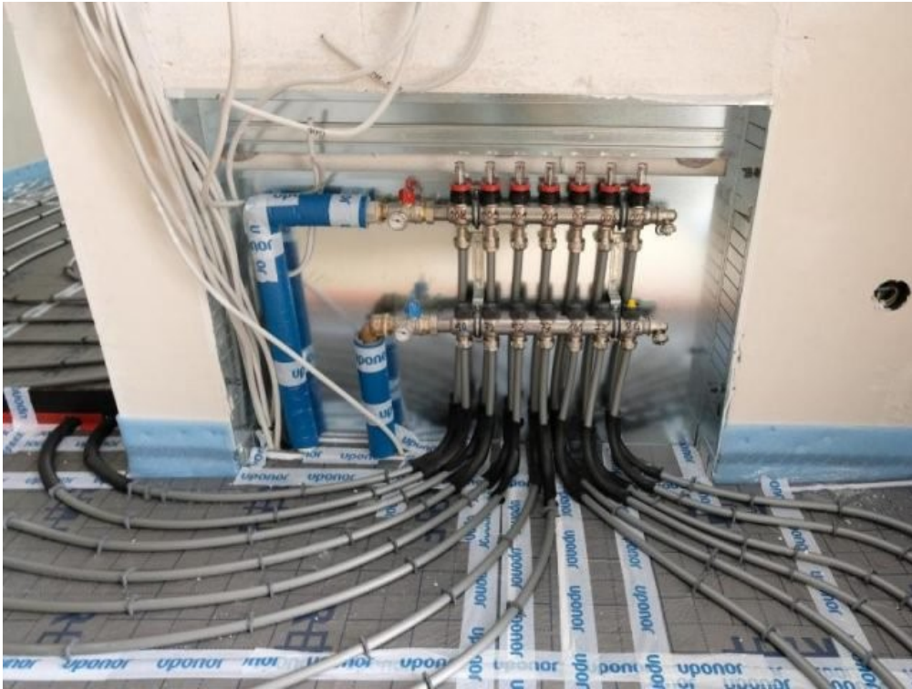
Leitungen einer Fußbodenheizung in einem Rohbau: Heizungstechniker sind in Deutschland sehr begehrt. Foto: Sebastian Willnow/dpa
